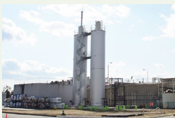
〈排水処理設備ICリアクター(南部事業所)〉
